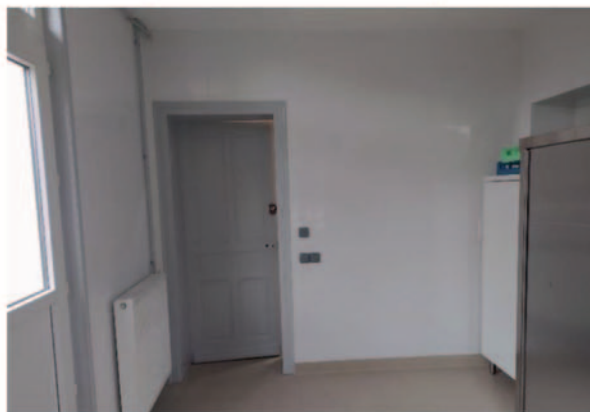
Pose de carrelages et faïences, remplacement des néons, prises de courant....
