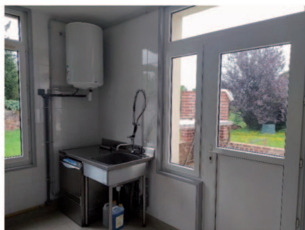
Installation d'un lave-vaisselle, remplacement de l'évier et de la robinetterie, du chauffe-eau.
